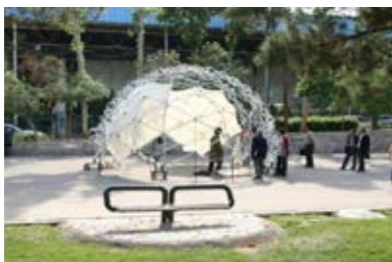
ت ۹. گنبد ژئودزیک باز و بسته شونده به قطر شش متر - دانشگاه تهران (۱۳۸۶).
