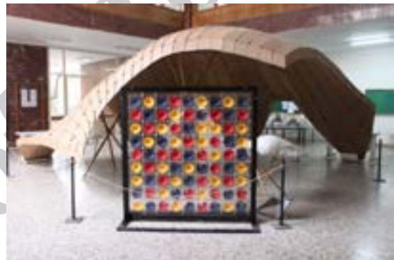
ت ۱۹. مدل مقوایی یک کفه از صدف دو کفه‌ای (مقیاس 1/1 )، در ساخت و برپایی صدف از هزار متر پلات و هزار گیره کاغذ استفاده شد.
