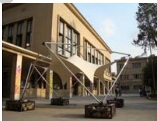
ت ۱۳. سازه کش بستی از پارچه پولی‌استر با روکش PVC کابل‌ها و مهارکش‌ها و لوله‌ها از جنس استیل با اتصالات تراشکاری و آبکاری شده ( دانشگاه تهران ۱۳۸۸ ).
