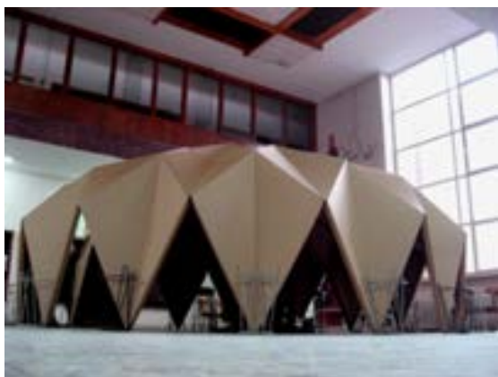
ت ۱۱. گنبد مقوایی به قطر شش متر، متشکل از صفحات ناشو و گیره - دانشکده معماری و شهرسازی دانشگاه شهید بهشتی (۱۳۸۶).
