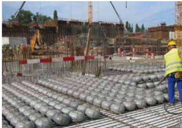
در فناوری Cobiax بار مرده غیرسازه ای حذف و خاصیت مقاومت دو محوره حفظ می گردد. همچنین با شکل گیری غشای بتونی مستحکم در قسمت فوقانی و تحتانی دال به همراه شکل گیری شبکه تیرچه های داخلی در دو امتداد در اثر قراردهی گوی های توخالی در سرتاسر فضای میانی دال بتونی می توان باربری مناسبی را برای این دال متصور شد.
