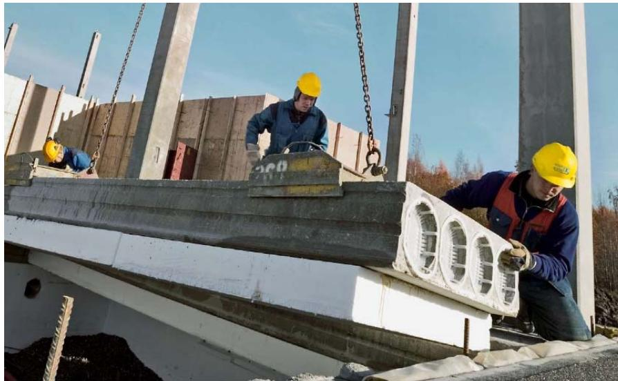
در صورت پیش تنیده بودن قطعات Hollow core ، لازم است ضوابط آیین نامه ACI 318 و آیین نامه طرح و محاسبه قطعات پیش تنیده (نشریه ۲۵۰ سازمان مدیریت) انجام شود : رعایت حداقل رده بتن مصرفی معادل  $C_{30}$  الزامی است و مقاومت گسیختگی انواع فولادهای آن باید بین  $1200 N/mm^2$  تا  $2200$  و محافظت فولادهای پیش تنیدگی در برابر زنگ زدگی بسیار حائز اهمت باشد.
