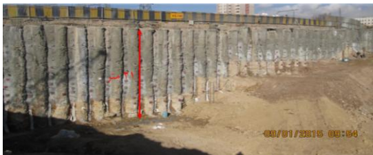
شکل ۱۴- پایدارسازی دیواره غربی توسط شمع های بتنی درجا
