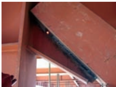
نمونه‌ای از اتصال جوشی در مهاربند سافتمان
