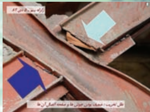
علل تخریب: ضعیف بودن جوش‌ها و صفحه اتصال آن‌ها
