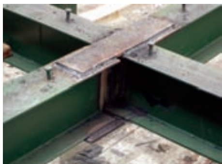
نمونه‌ای از اتصال جوشی در مهاربند سافتمان
