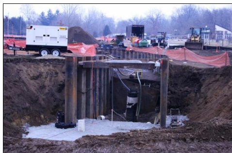
شکل (۲۳) بستن خیابان به منظور ساخت زیرگذر عابر پیاده
