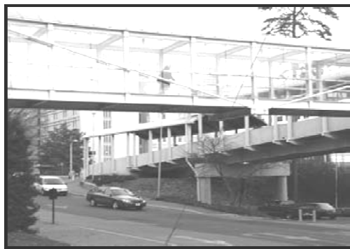
شکل (۱۹) احداث روگذر عابر پیاده با توجه به توپوگرافی منطقه
