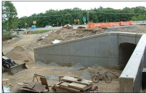
شکل (۲۴) احداث زیرگذر عابر پیاده بدون مشکلات در مسیر ترافیک
