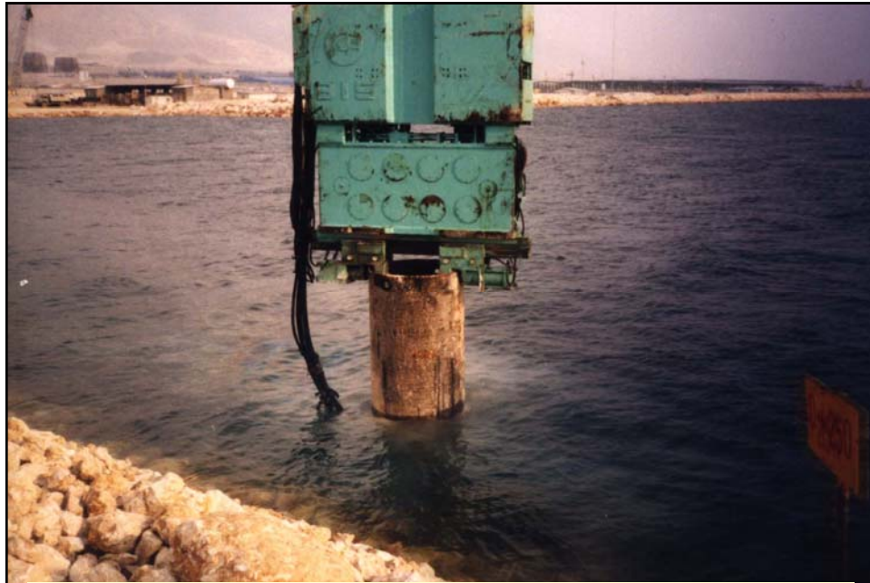
مرحله نهایی کوبش شمع فلزی با چکش ارتعاشی
