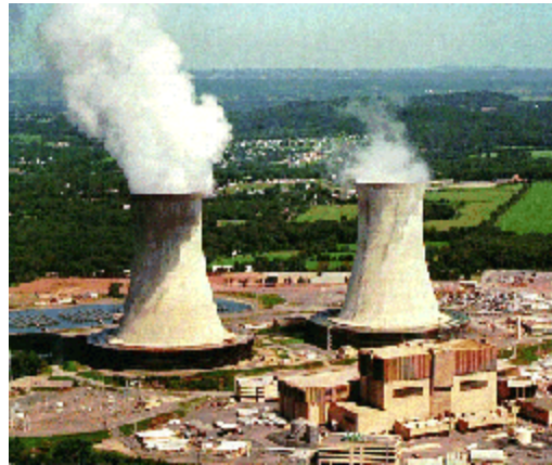
شکل 1-11- تصویری از Cooling towerهای طبیعی مورد استفاده در صنعت
