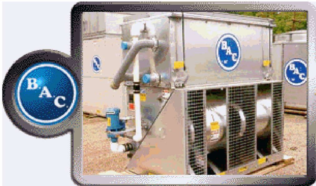
شکل 11-7- تصویری از Cooling tower نوع مکنده
